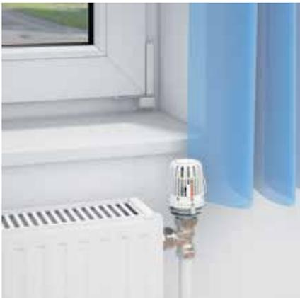
**Incorrecto:** La cabeza termostática con sensor integrado no se debe montar verticalmente.
