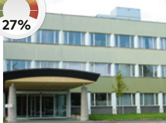
MOL, gruppo ungherese operante nel settore del petrolio e gas naturale - Impianto HVAC Centro Direzionale Risparmio energetico del 27%
