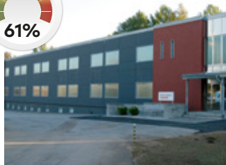
Hammarplast AB, Svezia Impianto di raffreddamento industriale Pompaggio risparmio energetico del 61%
