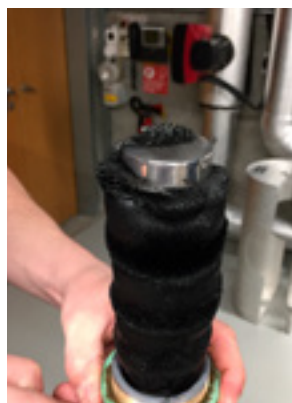
En stor Ferro-Cleaner invändigt Exempel på Ferro-Cleaners effektivitet
